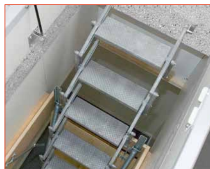
» Extension d'escalier escamotable (plenum 3)
